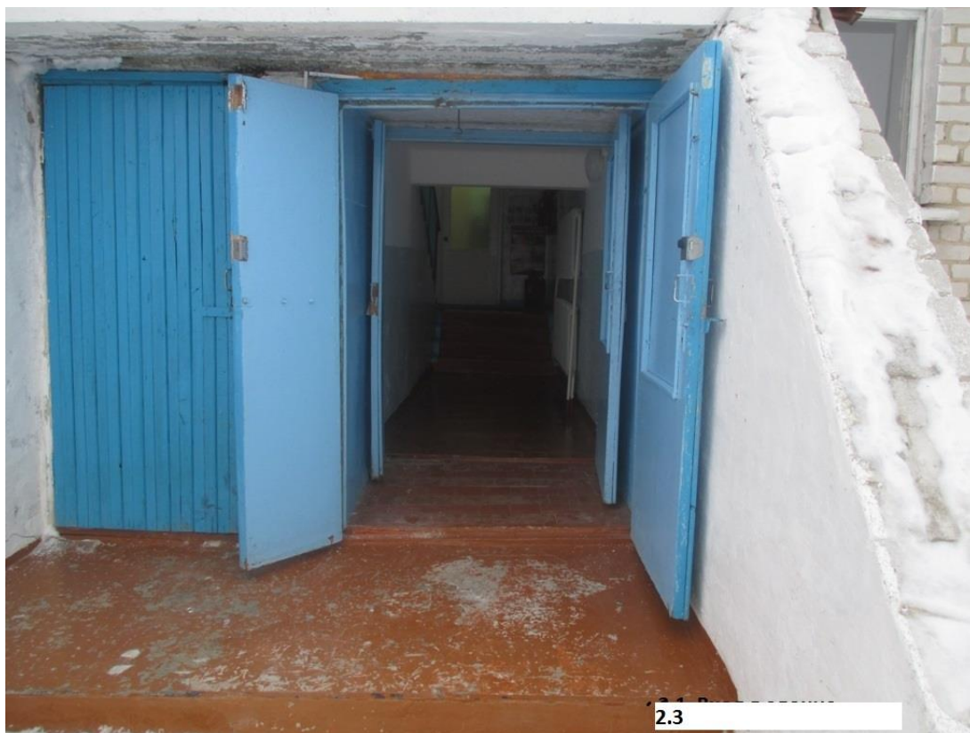
2.3 Входная площадка (перед дверью)
